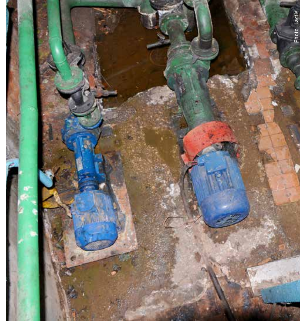
Les moteurs électriques ont été démontés et le niveau d'exploitation adapté aux besoins réels de pompage.
