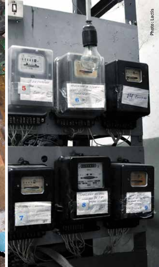
Des compteurs électriques d'occasion ont été installés pour faciliter la prise de mesures individuelles.
